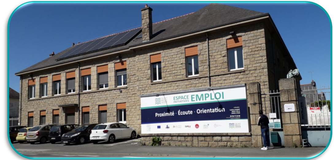
Toiture ardoise avec panneaux en surimposition de l'Espace Initiative Emploi
