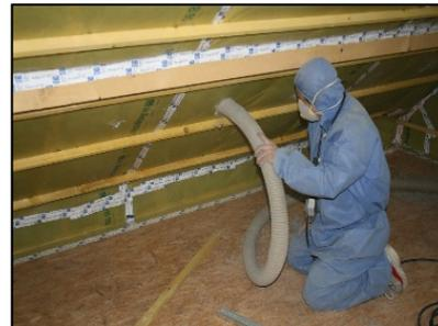
Néanmoins, cette méthode présente un défaut majeur : il n'est pas possible de vérifier l'homogénéité de l'isolant insufflé. De plus, certains professionnels travaillent en soufflant dans des chaussettes qui sont censées combler les volumes. Dans ce cas, la répartition de l'isolant peut être problématique puisque la lame d'air, pourtant impérative, peut être réduite, voir supprimée.
