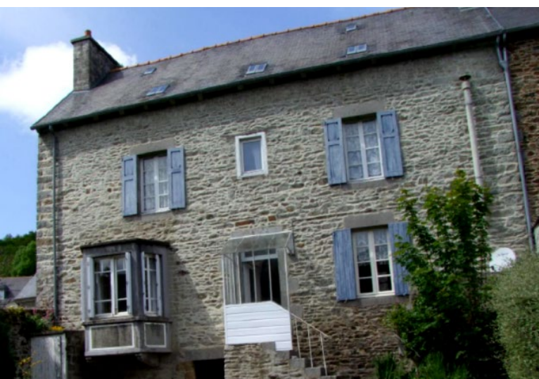
MAISON ANCIENNE EN PIERRE
