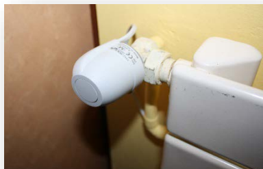
Vanne thermoélectrique filaire installée sur un radiateur
