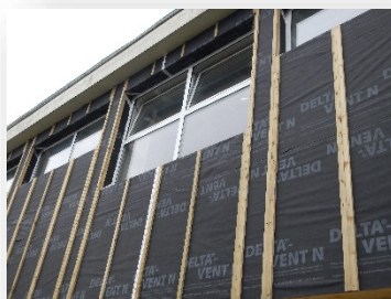
Pendant les travaux
