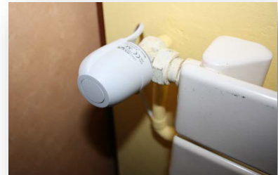
Vanne thermoélectrique filaire installée sur un radiateur
