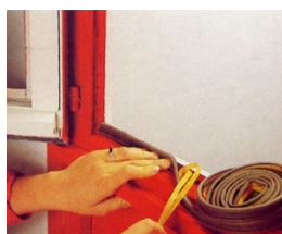
Figure 1: Pose d'une bande adhésives
