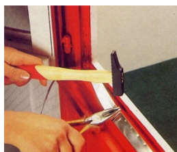
Figure 2: Pose d'un joint métallique
