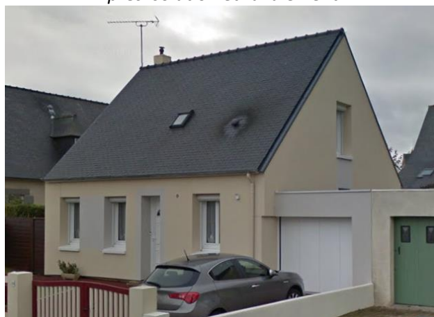
Après isolation et ravalement :
