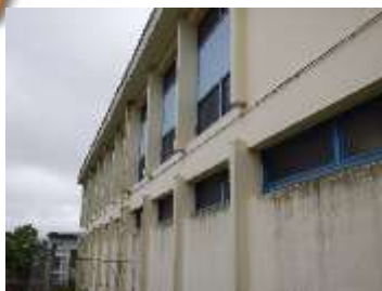
Avant les travaux
