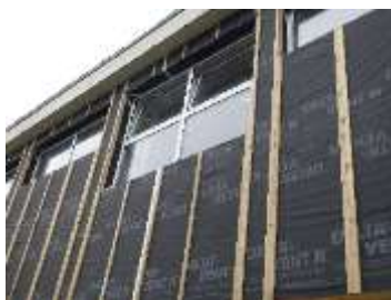
Pendant les travaux
