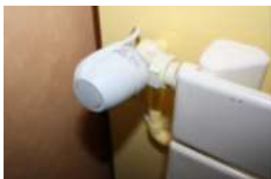
Vanne thermoélectrique filaire installée sur un radiateur
