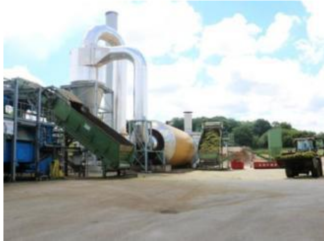
Exemple sécheur Codéma à Changé (53)
